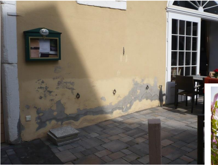
SCHLOSS MIEL (REMISE) vor der Sanierung
